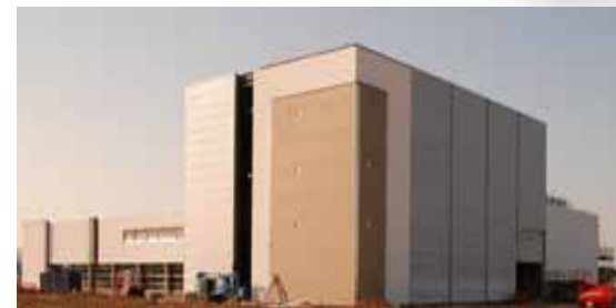
欧州ナレッジセンター 生産棟
