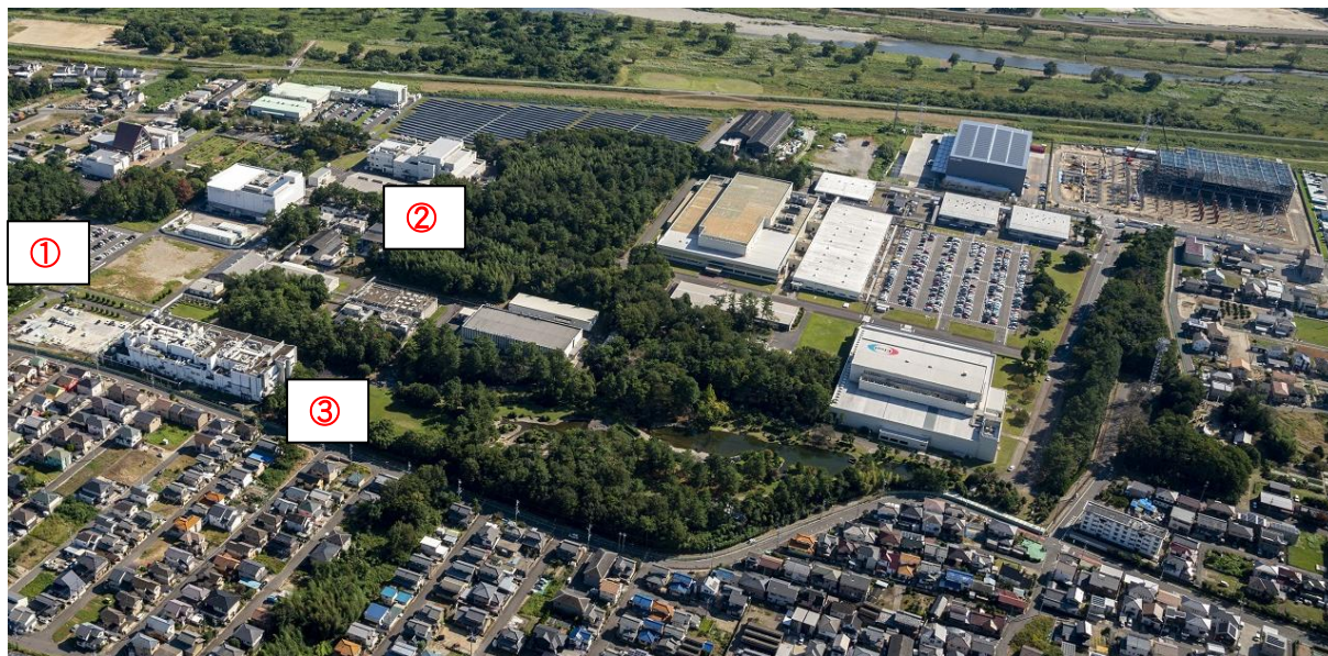
(写真:川島工園全景:①新注射剤棟/研究棟の予定地、②治験薬棟、③現在の研究棟)
